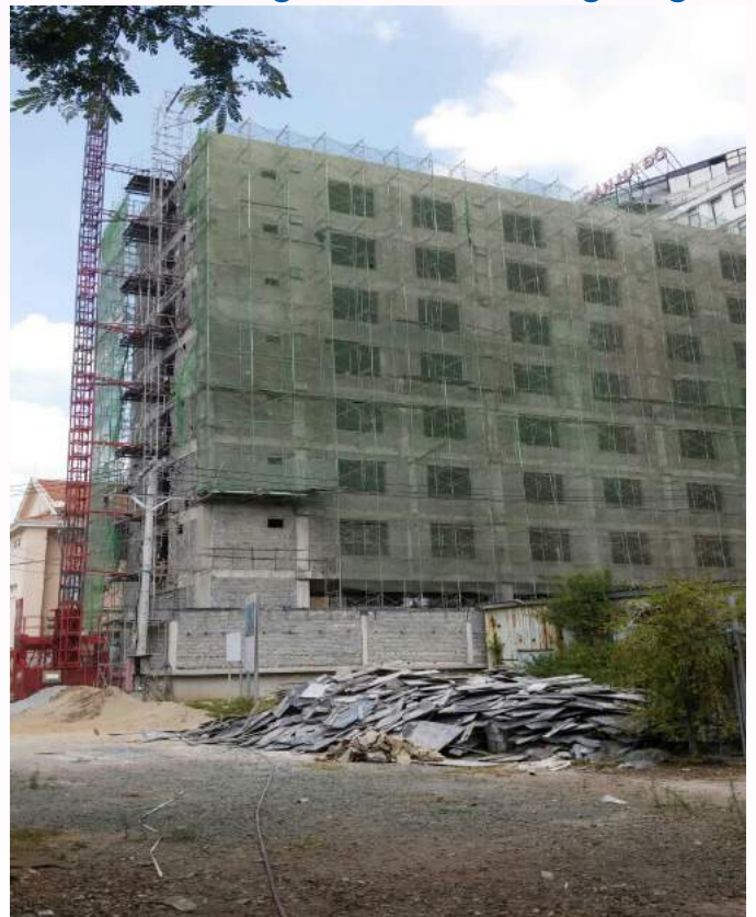
Nhà cao tầng được xây dựng bằng gạch không nung
