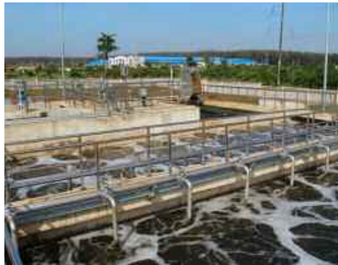
Nhà máy xử lý nước thải Thuận An
