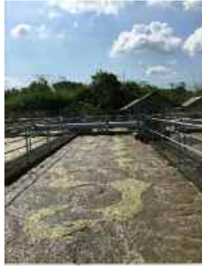
Hình 2: Bể hiếu khí sử dụng đĩa phân phối khí (mới)
