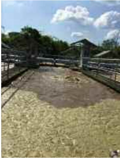
Hình 1: Bể hiếu khí sử dụng màng thổi khí (cũ)
